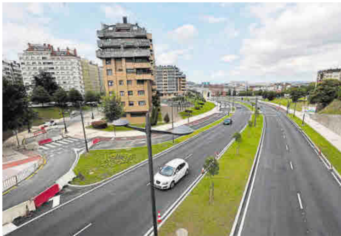
Las obras de la Ronda Sur, ayer, vistas desde el puente de Melchor García Sampedro.
